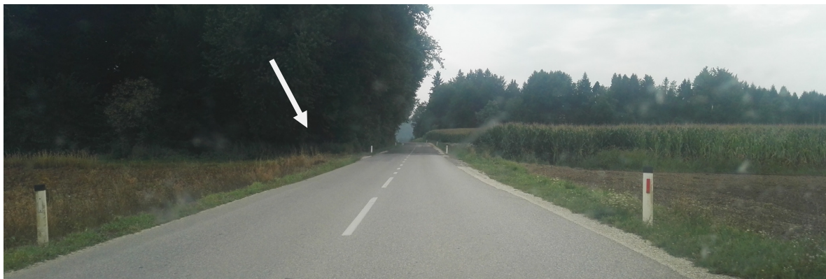
Pogled na cestni priključek obstoječe poljske poti iz smeri Vodice
